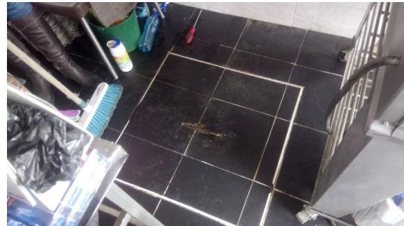
Fotografía 2. Tapa de tableta cerámica en el aljibe.
