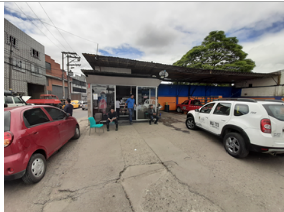
Fotografía 2. Caseta donde se encuentra el aljibe
