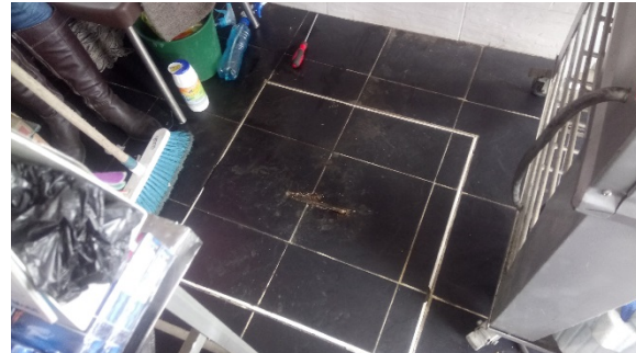
Fotografía 2. Tapa de tableta cerámica en el aljibe.
